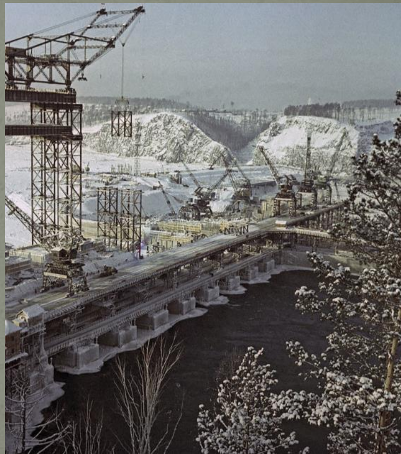
Строительство Братской гидроэлектростанции. Вид на плотину. 1960 год
